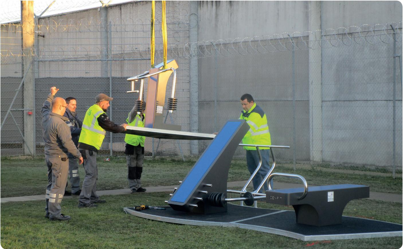
FitPoint hat einen Hebepunkt für eine einfache Installation auf jeder flachen Oberfläche ohne Verankerung.
